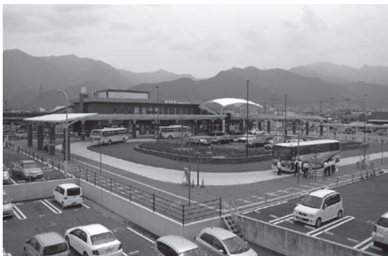
完成した駅前広場と改修された新居浜駅
