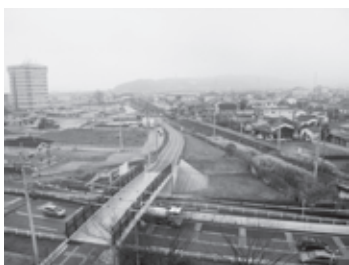
左端の建物は駅の西側にあるテレコムプラザビル
